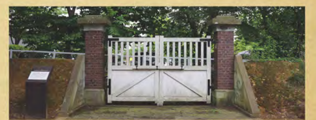
現在の通用門門柱 平成27年のリニューアルオープンに合わせて、通用門を復原した。門扉は失われていたが、昭和18年に通用門とともに木製扉から鉄製扉に変更されている別の門扉の古写真から推測したものである。
