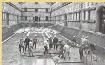
1980年代の工事の様子 第1棟の外壁を保存しながらコンクリートを打設している。内側の梁や柱は全て撤去されていることが分かる。
