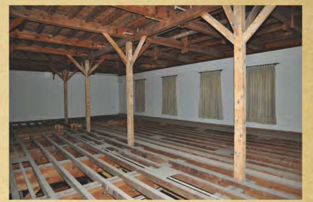
第3棟に残る梁と柱(非公開エリア) 歴史博物館改修工事においては、第3棟を補修する材料の多くが、第1棟や第2棟から転用されており、木造部分が多く残されている。
