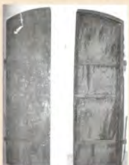
第3棟キャットウォーク側窓鉄扉(建築当初)
