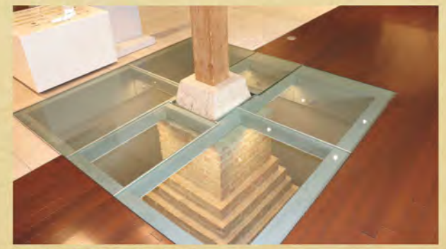
煉瓦造の基礎の現状保存展示 東石下から1,370mm煉瓦を積み、上部幅700mm四方、下部幅1,300mm四方の大きさである。
